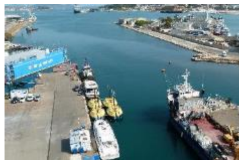
7. Site de Toulon 22.000m 2 de terrain sécurisé, 2500m 2 d'atelier et 200m de quai
