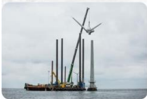
Installation et déconstruction du parc de Vindeby
