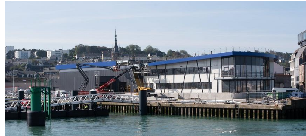
Base de maintenance pour le parc éolien en mer de Fécamp
