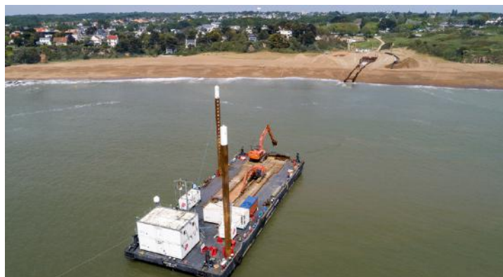
Chantier de raccordement du parc éolien au large de Saint Nazaire (avril 2020) © RTE
