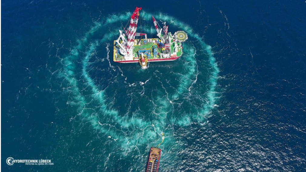
Double rideau de bulles (DBBC) (©Hydrotechnik Lübeck GmbH)
